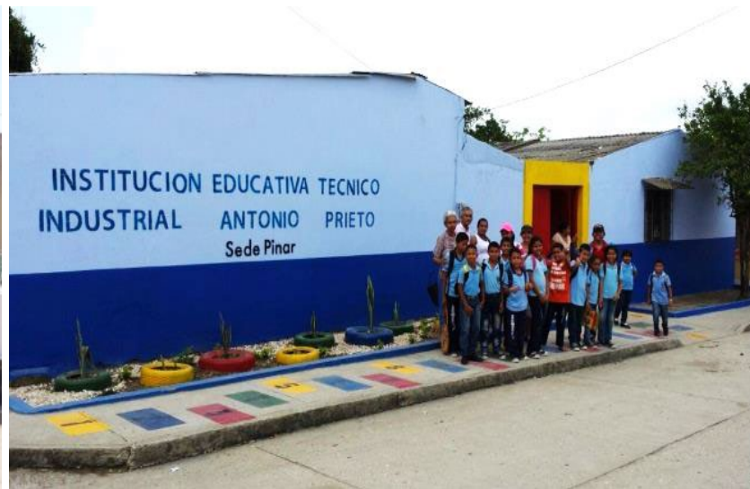
Imagen 2: Fachada Principal IETIAP Sincelejo - Sucre (Después) Fuente: Fotografía Diego Andrés Covo Ordosgoitia
