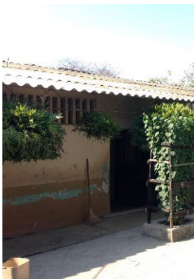
Imagen 3: Fachada Aulas IETIAP Sincelejo - Sucre (Antes)
