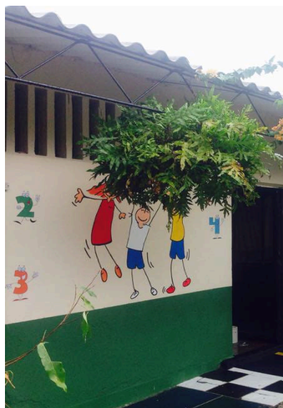
Imagen 4: Fachada Aulas IETIAP Sincelejo - Sucre (Después)
