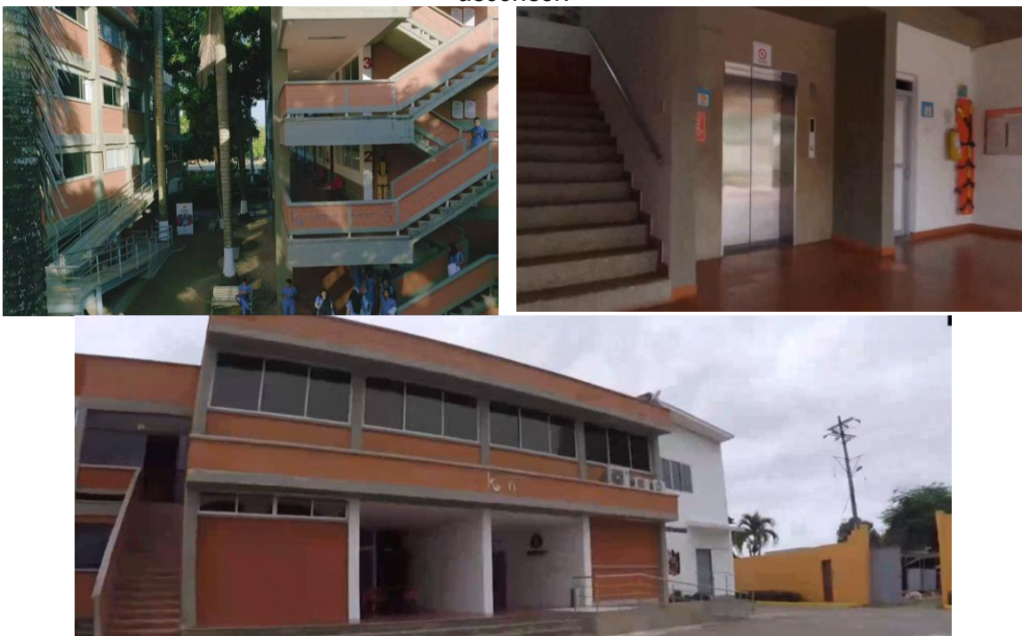
Figura 18. Adecuación de infraestructura con rampas de acceso e implementación de ascensor.
