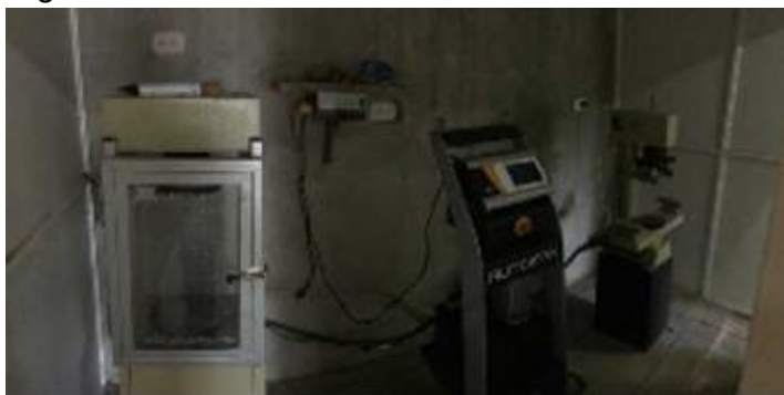
Figura 6: Vista General del Laboratorio de Materiales para Hormigón y Pavimentos.
